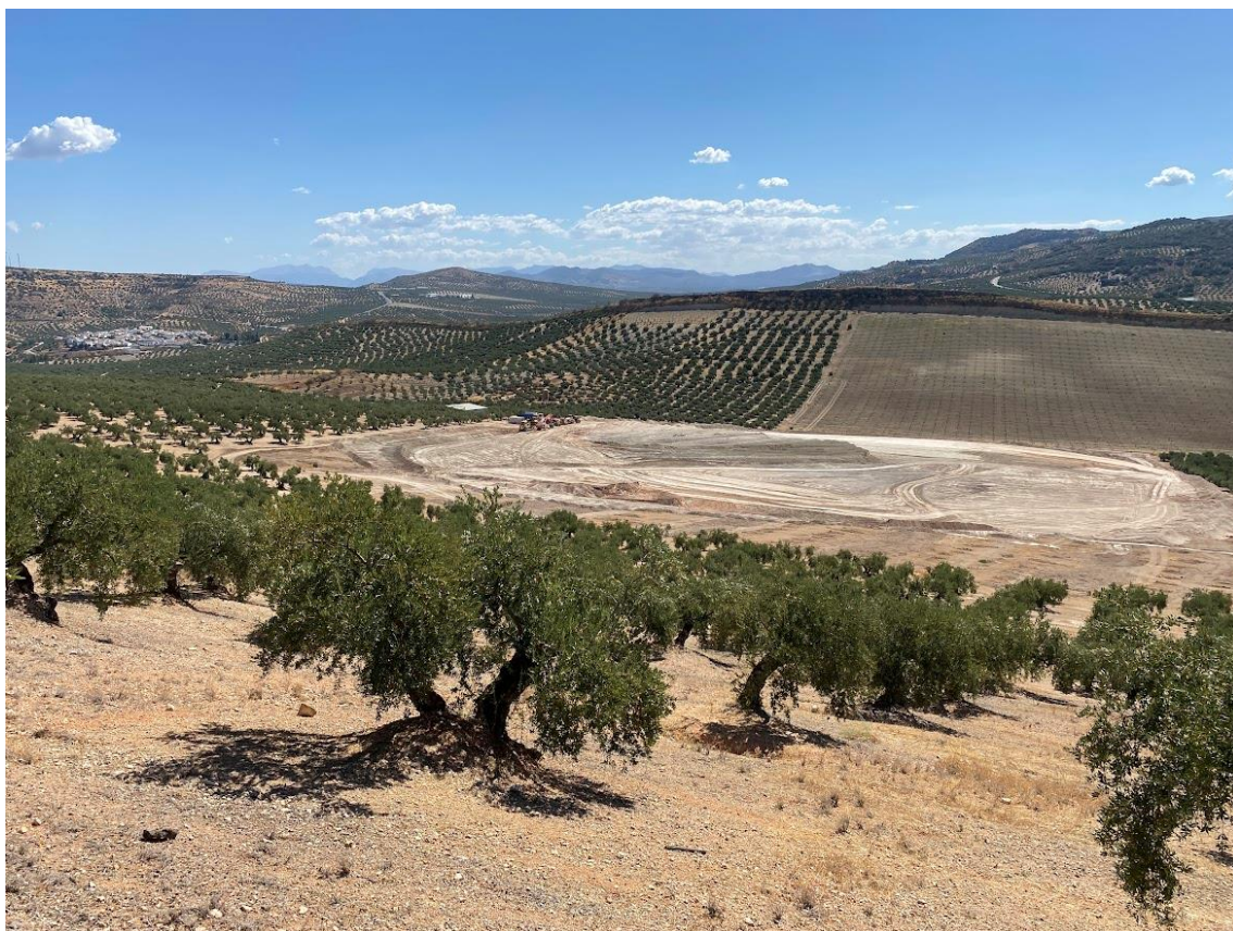
Movimientos de tierras para la construcción de la balsa en parcela próxima a El Cañuelo.
